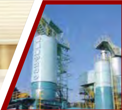
アスファルト・プラントの外観
